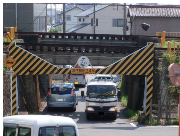
写真-2 踏切道西側の近鉄架道橋
